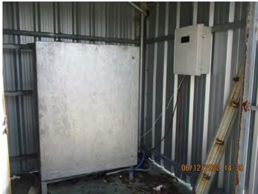
ภาพที่ 2-6 เครื่องตรวจวัดอุณหภูมิ และความเข้มข้นคลอรีนแบบอัตโนมัติของน้ำทิ้ง จากรางระบายน้ำทิ้งของโครงการ
