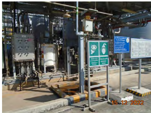
ภาพที่ 2-23 จุดชำระล้างร่างกายและล้างตาฉุกเฉินในบริเวณที่มีการขนส่งหรือกักเก็บสารเคมี
