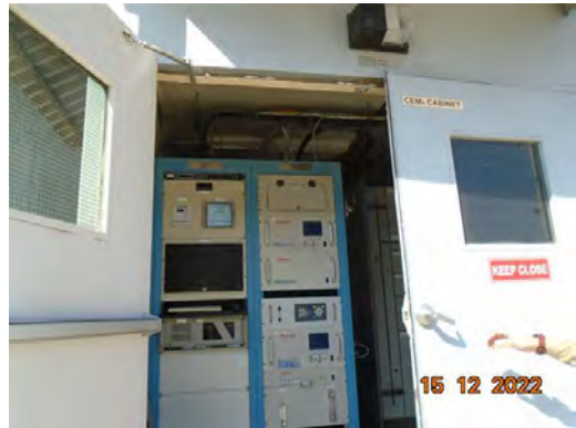
ภาพที่ 2-2 ระบบตรวจวัดคุณภาพอากาศที่ระบายจากปล่องระบายอย่างต่อเนื่อง (CEMs)
