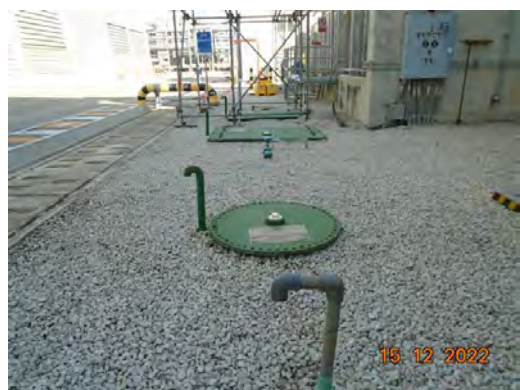
ภาพที่ 2-5 บ่อพักน้ำเสียจากการล้างเครื่องจักร/อุปกรณ์
