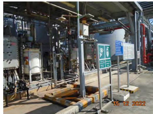
ภาพที่ 2-23 จุดชำระล้างร่างกายและล้างตาฉุกเฉินในบริเวณที่มีการขนส่งหรือกักเก็บสารเคมี
