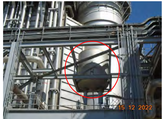
ภาพที่ 2-12 ซิลเลนเซอร์ (Silencer)
