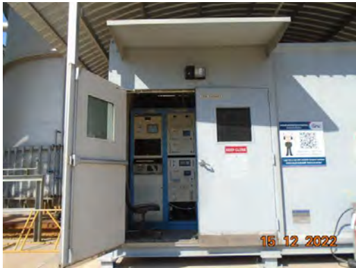
ภาพที่ 2-2 ระบบตรวจวัดคุณภาพอากาศที่ระบายจากปล่องระบายอย่างต่อเนื่อง (CEMs)
